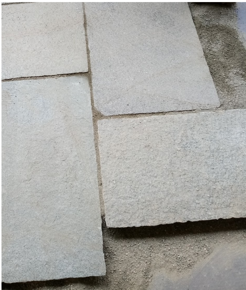
Pavimentazione prevista per la carreggiata in lastre di pietra di Luserna
