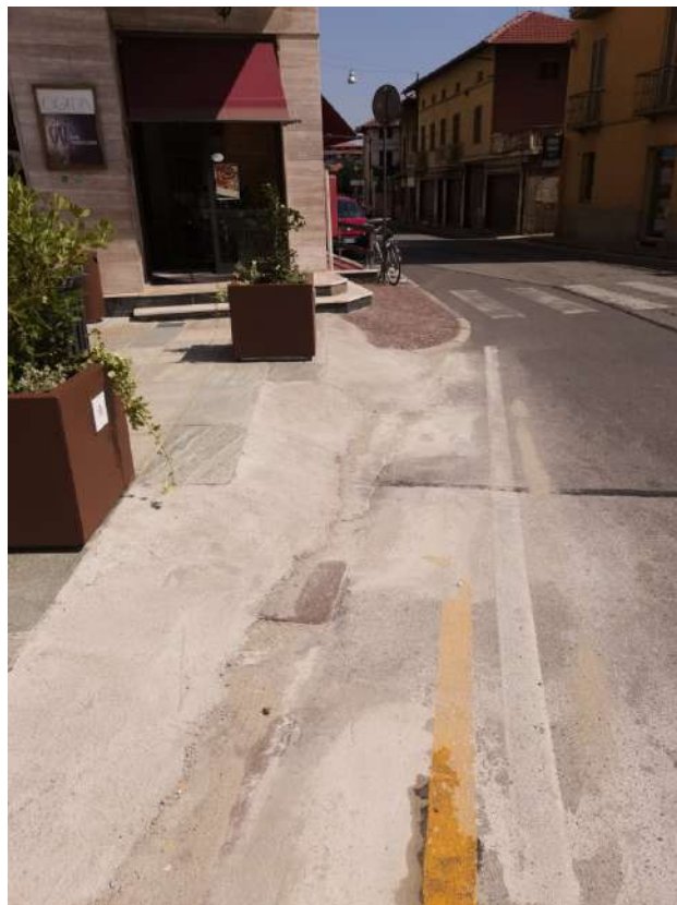
Particolare della pavimentazione da raccordare alla nuova piattaforma
