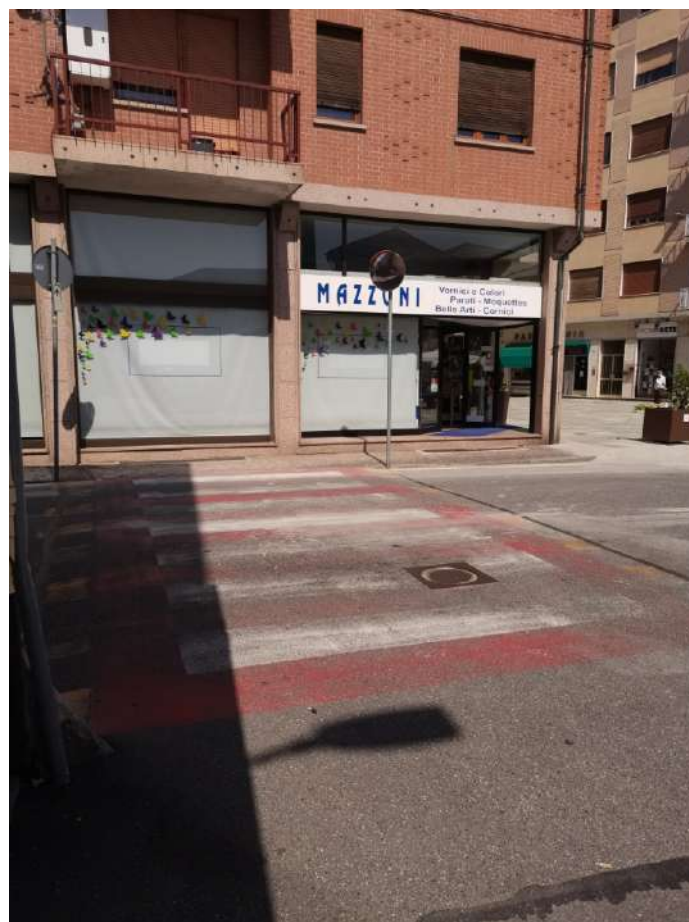
Attraversamento pedonale a sud rialzato
