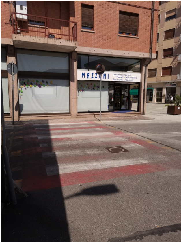
Attraversamento pedonale a sud rialzato
