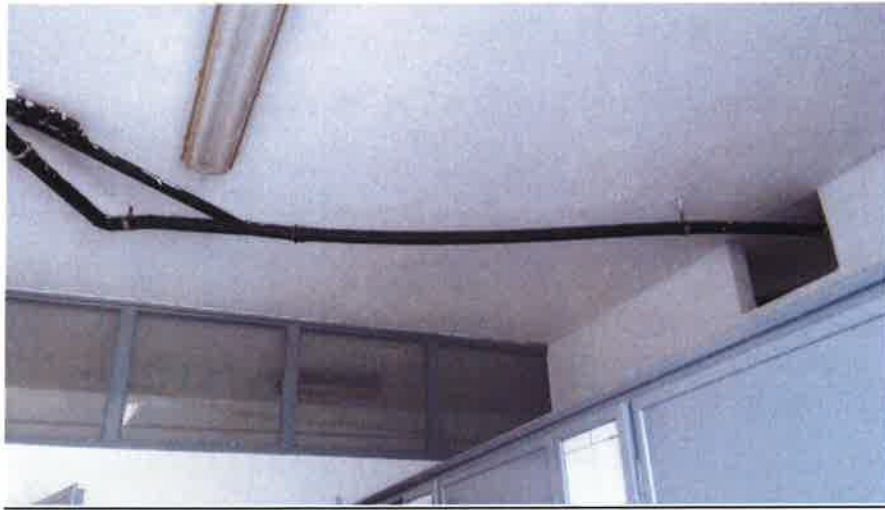
Bagno piano primo
