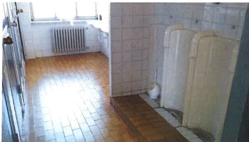
Bagno piano secondo
