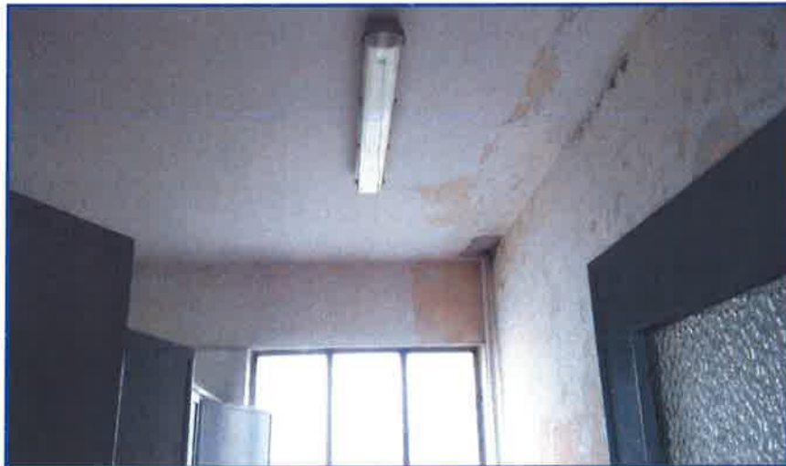
Bagno piano secondo
