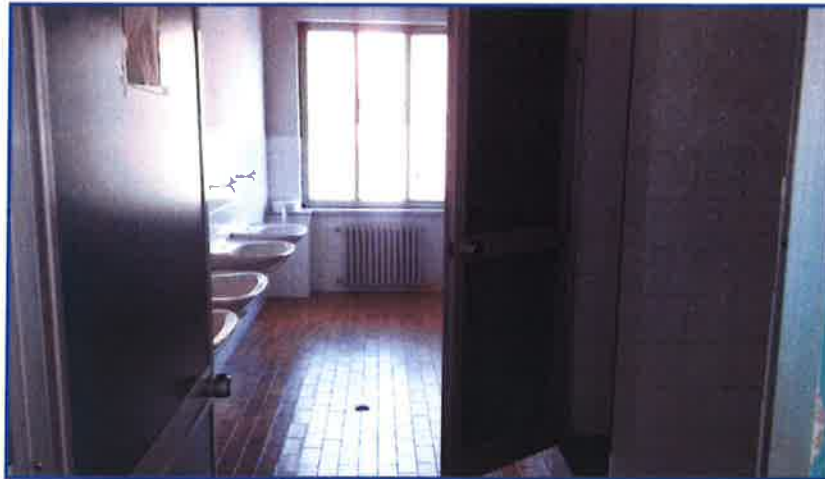
Bagno piano secondo
