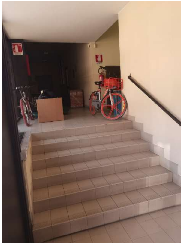
Scalinata di ingresso al corridoio su C. so Nazioni Unite
