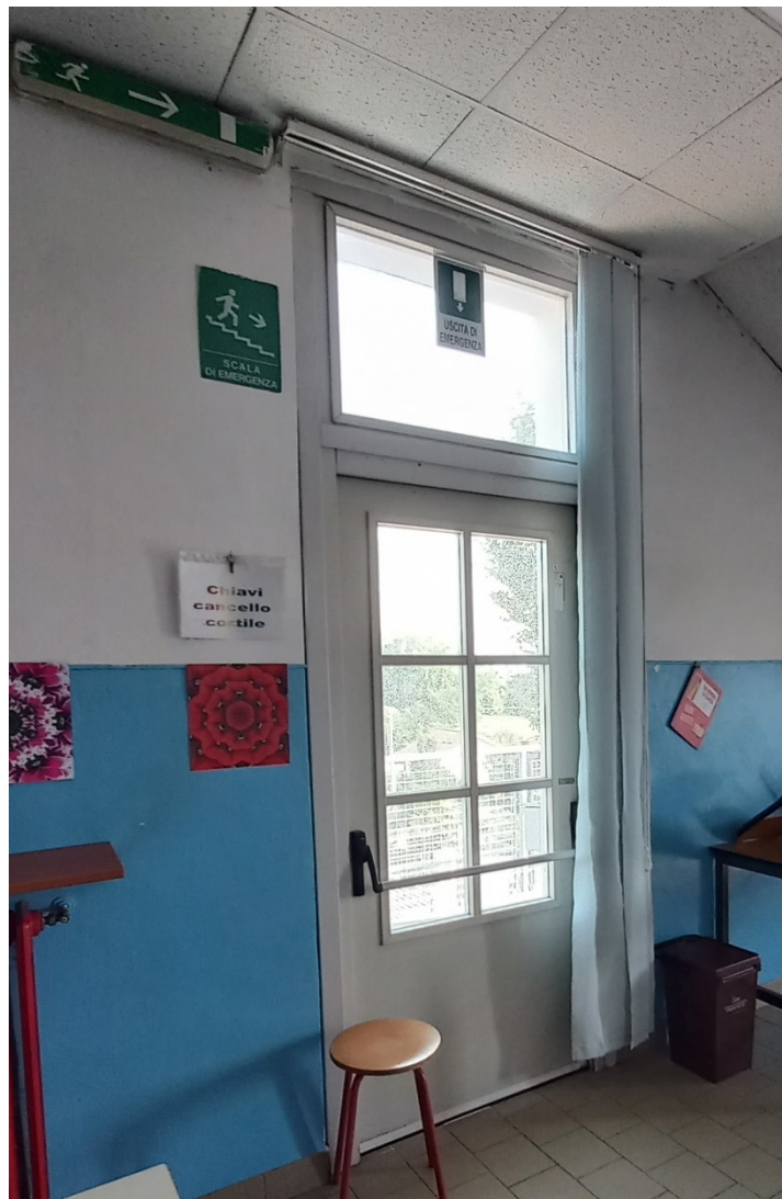
Facciata est - Porta telaio in legno spessore 6 cm, 1 anta, dim. 120 cm base x 225 cm altezza; con sopra luce fisso, telaio in legno 6 cm, dim. 120 cm x 80 cm - Vetrocamera 8 mm
